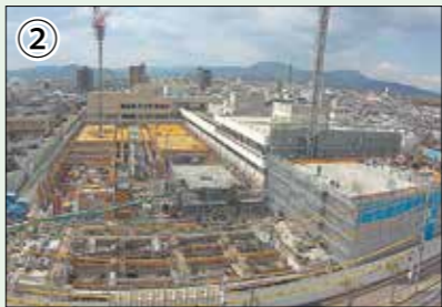
【3月8日】 議会棟のコンクリート打設は北半分が3階床まで完了、南半分は基礎部分を施工中です。
