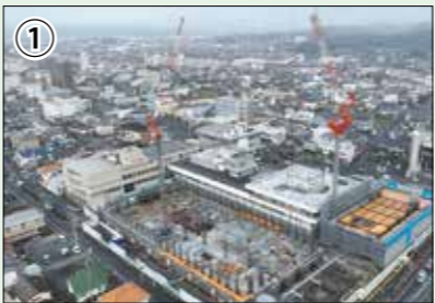
【2月20日】 構台（重機の通り道）の西半分を撤去しています。（ドローンにより撮影）
