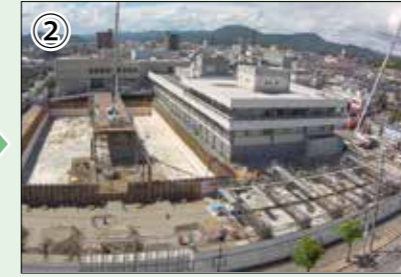
【9月5日】 庁舎棟の掘削工事は完了しました。議会棟では基礎の配筋工事をしています。
