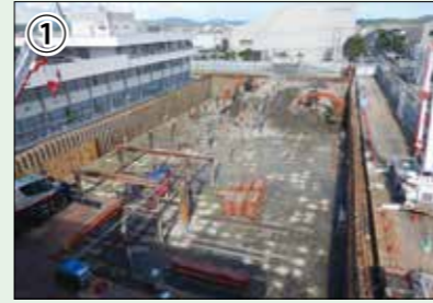
【8月22日】 庁舎棟では掘削工事と構台（重機の通り道）の組み立てを同時に行っています。
