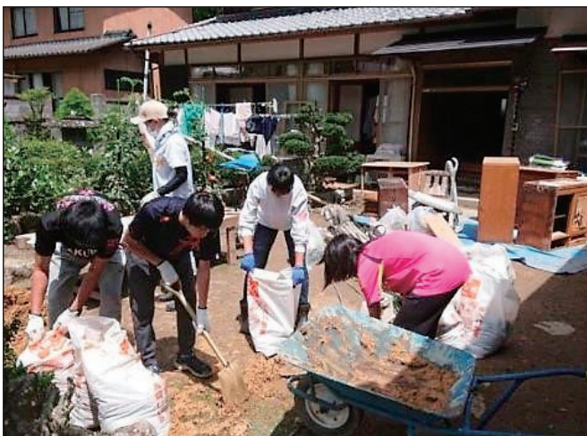
被災家屋での撤去作業
