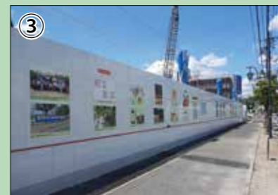
工事現場東側の仮囲いに「平成30年西日本豪雨災害からの復興」についてのパネルを展示しています。
