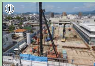
【7月22日】 議会棟側のくい打ち工事が始まりました。庁舎棟側では地盤改良工事を行っています。
