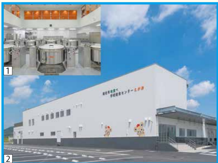
① 市内 34 の幼稚園・小中学校の給食約 7500 食を作る大釜 ② 外壁に描かれたチュッピーが給食の配送を見守る
