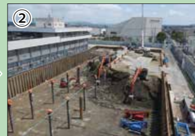
【8月9日】 西側から掘削工事を行っています。庁舎棟の半分ほど掘削が進んでいます。
