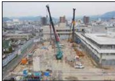
Ngày 6/6 Vừa đổ nền bê tông vừa đổ trụ bê tông chính
