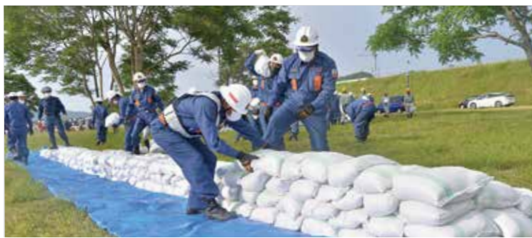
土のうを崩れないよう積み上げる
