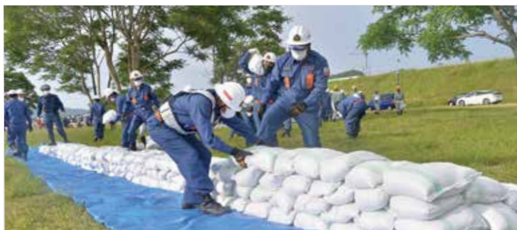
土のうを崩れないよう積み上げる
