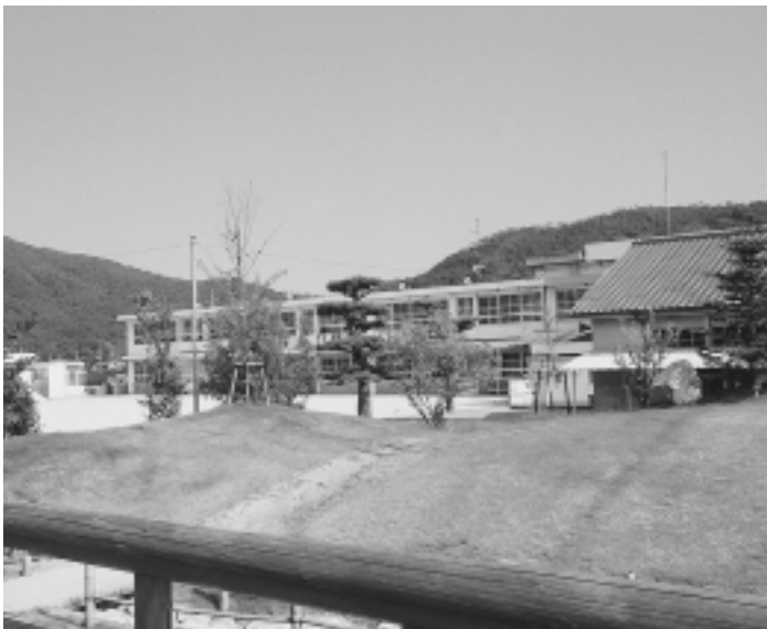
急務な耐震診断が必要な小学校
