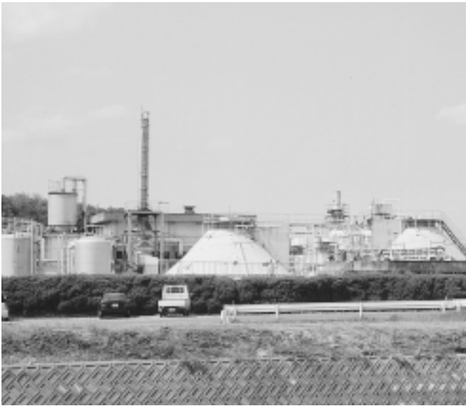
脱水汚泥の活用が期待される浄化園
