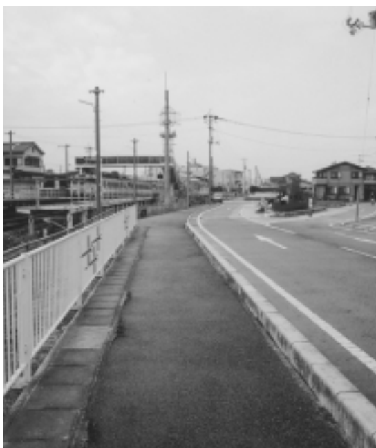
整備を要する東総社駅北口付近
