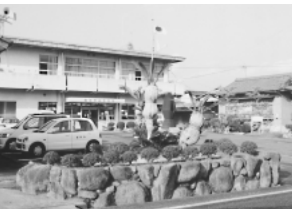
設備が整い接続が待たれる山手支所
