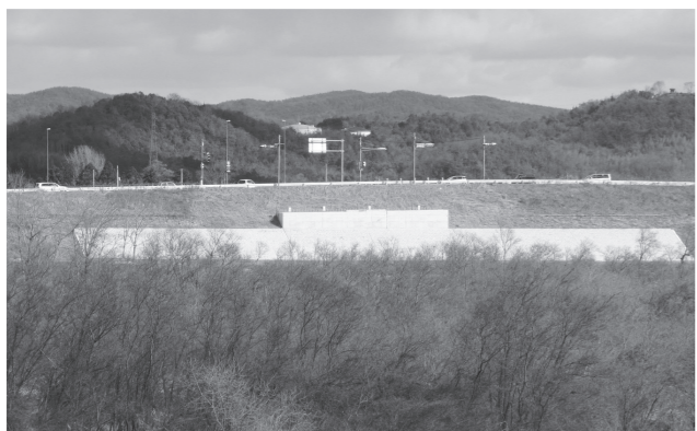
高梁川新架橋現場
