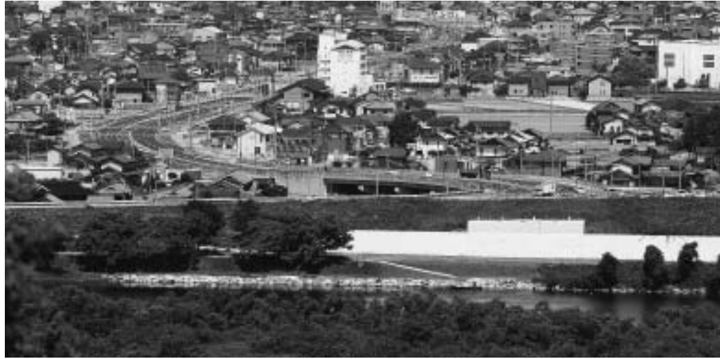
高梁川新架橋のあり方について審議会で検討されている
