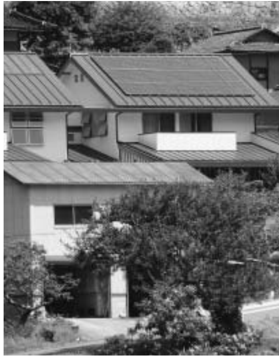
太陽光発電システム
