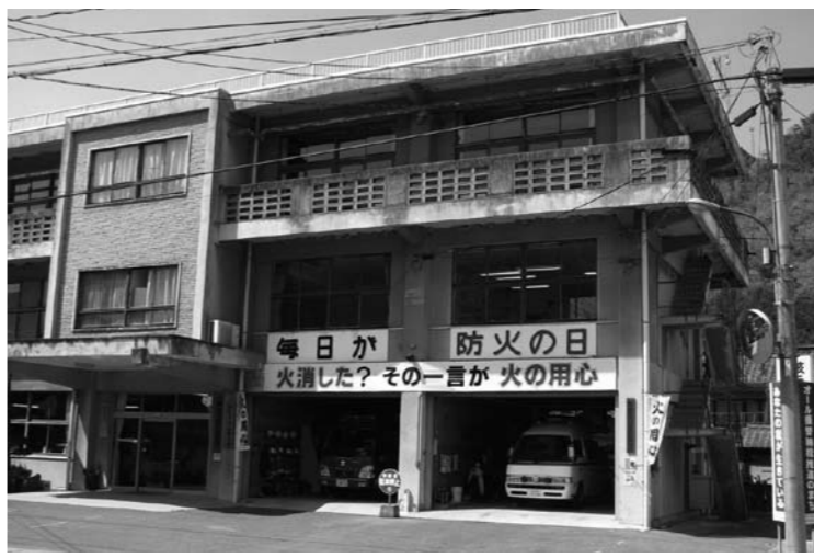
移転・改築への取り組みが議論された消防署昭和出張所
