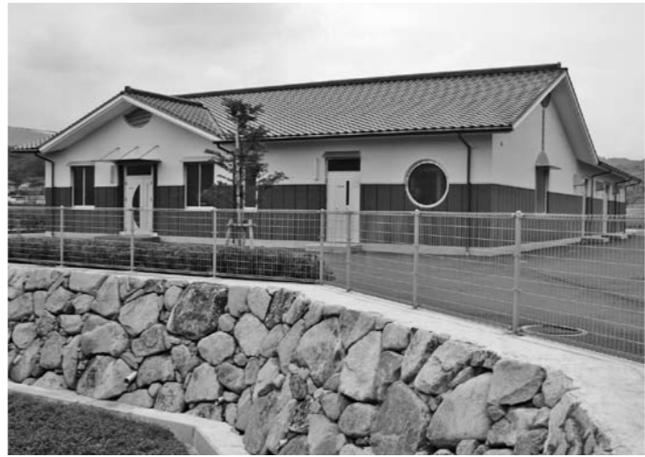
農業集落排水処理施設の新本新庄・山田浄化センター
