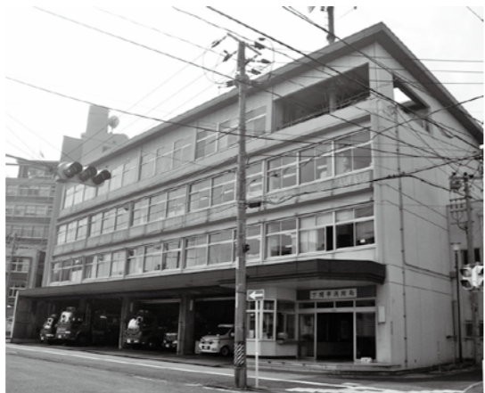
下関市消防局庁舎
