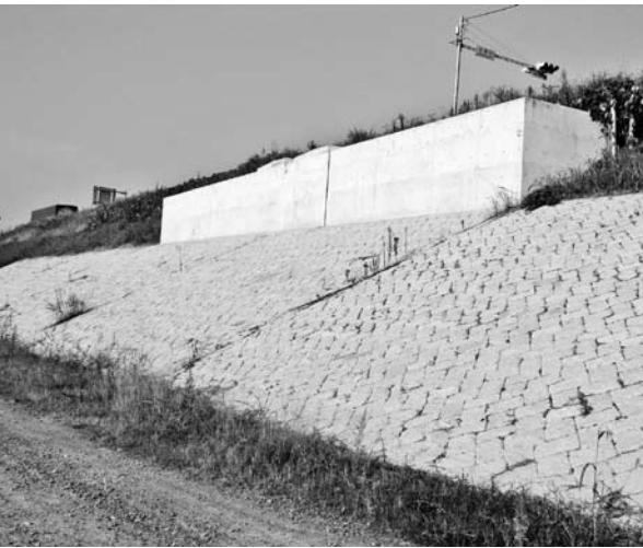
高梁川左岸（中原側）に完成している新架橋の橋台
