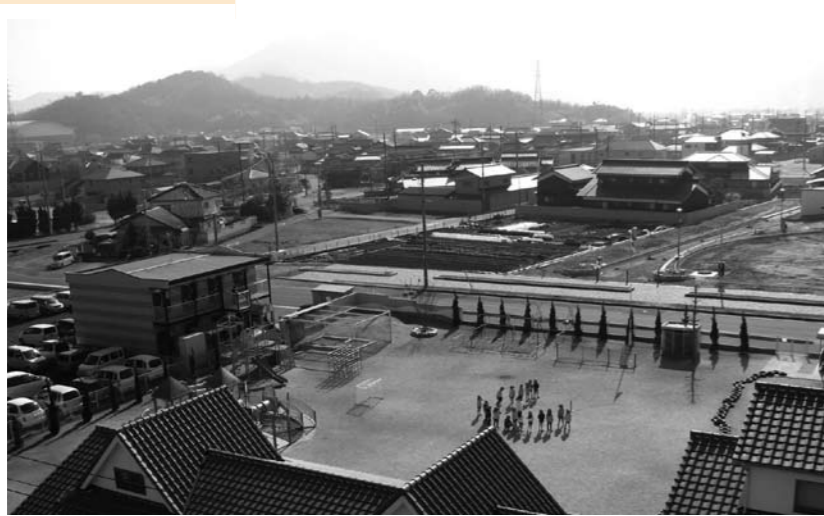
区画整理が進む総社駅南地区
