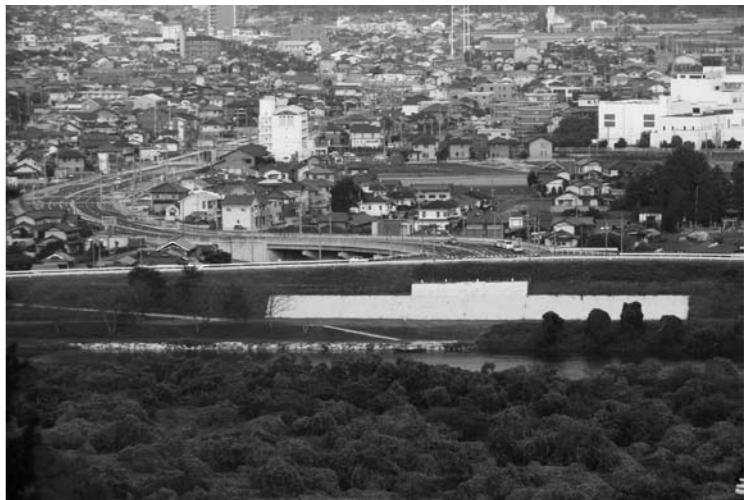
中原に橋台が完成している高梁川新架橋
