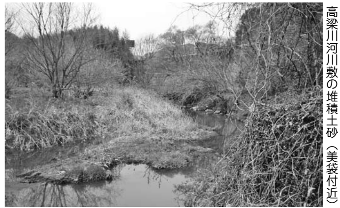
高梁川河川敷の堆積土砂(美袋付近)
