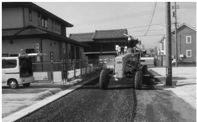
区画整理工事の様子
