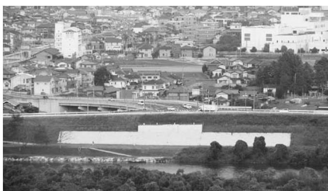
高梁川新架橋の橋台
