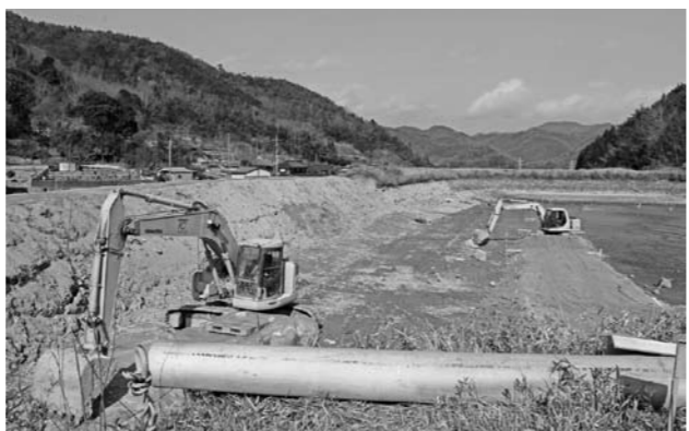
改修工事中の大谷池
