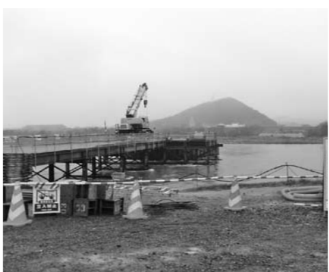
現在工事中の橋梁
