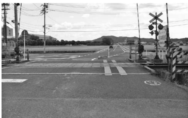
拡幅が望まれる服部停車場線の踏切
