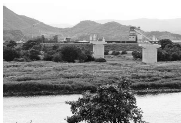
工事中の新架橋
