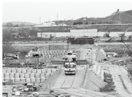
工事中の新架橋（本年3月末ごろ）
