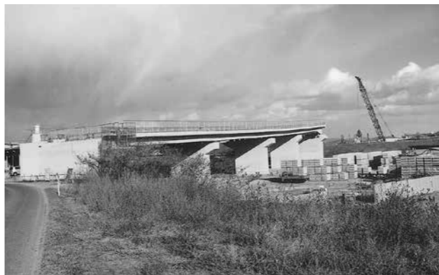
建設が進む高梁川新架橋
