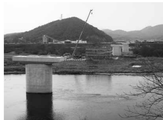
建設が進む高梁川新架橋
