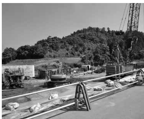
復旧が進められる広野町
