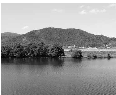
樹木伐採が進められている高梁川
