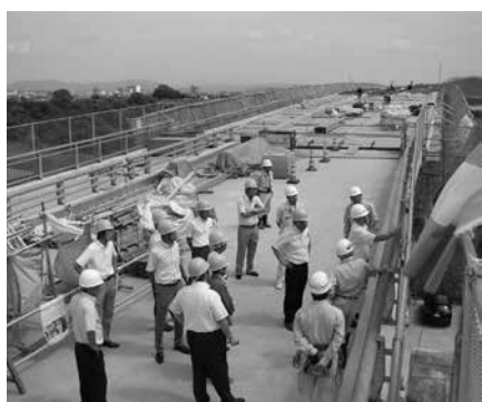
建設消防委員会では新総社大橋建設現場を視察
