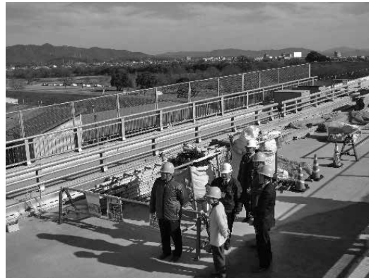
開通が遅れると公表された高梁川新架橋
