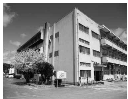
解体される総社小学校既存校舎
