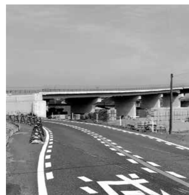
早期の完成が望まれる新総社大橋
