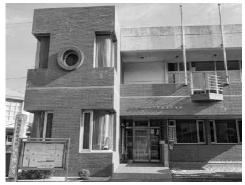
昭和52年に建てられた中央公民館池田分館。老朽化のため、移転新築する
