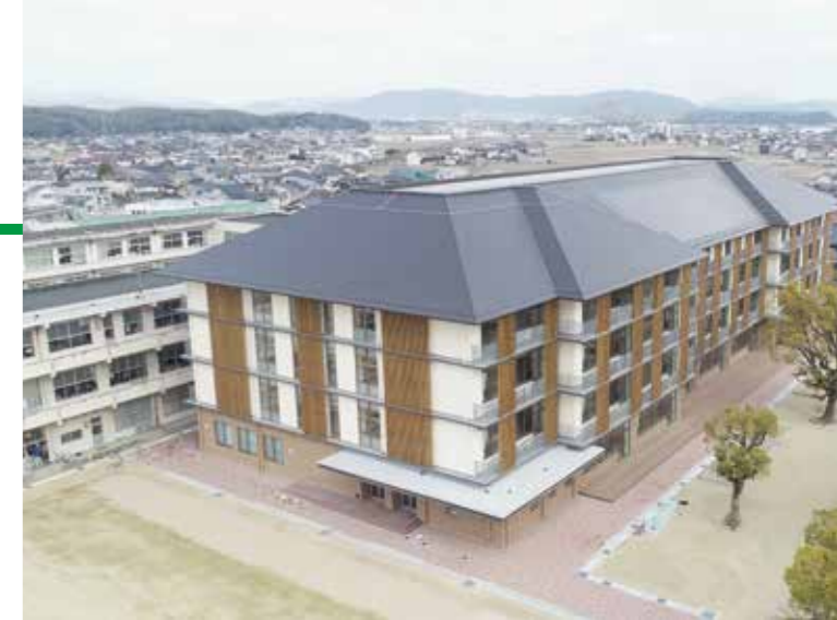
完成した新校舎。左奥が旧校舎
