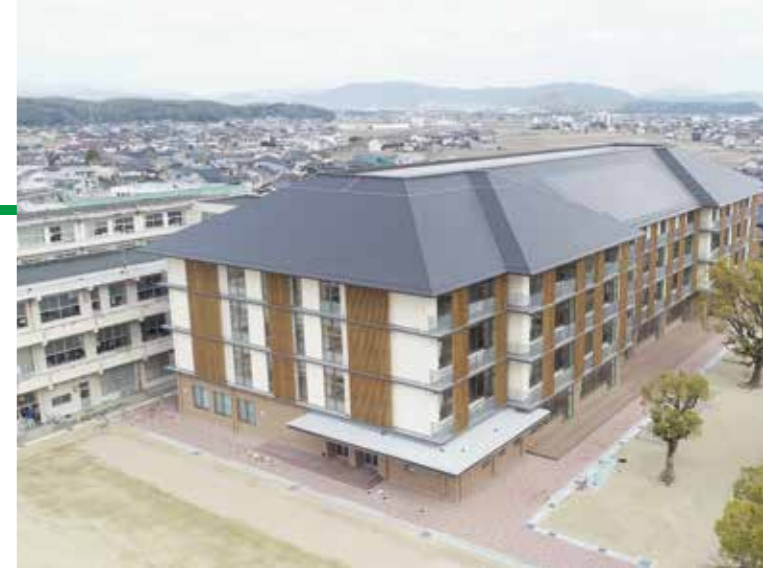
完成した新校舎。左奥が旧校舎
