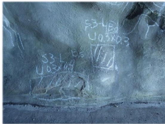
吹付コンクリートのひび割れ及びうき
