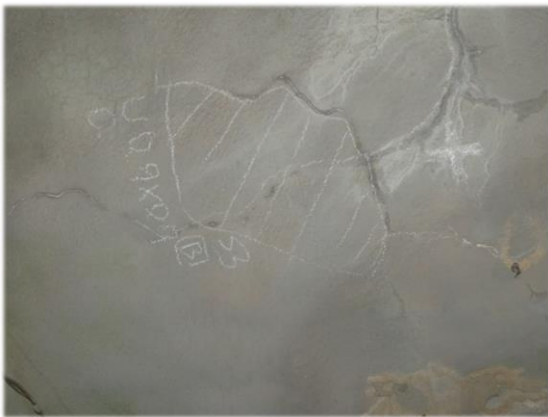
吹付コンクリートのひび割れ及びうき
