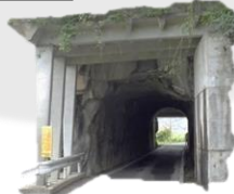
滝の端2号洞門
