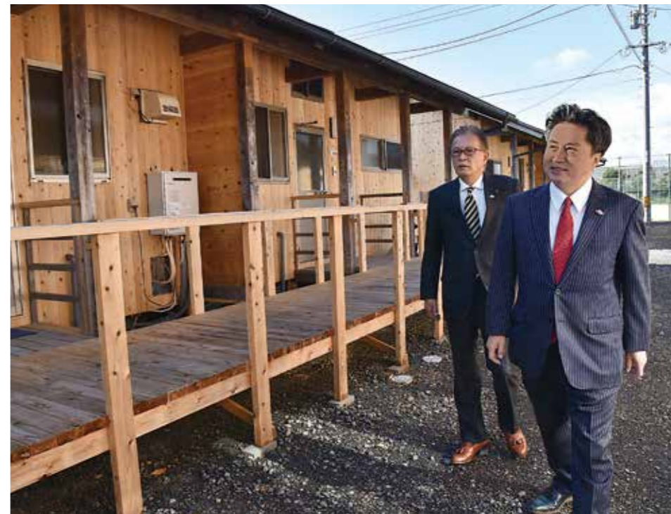
西公民館前に建設した仮設住宅を見て回る市長と議長
