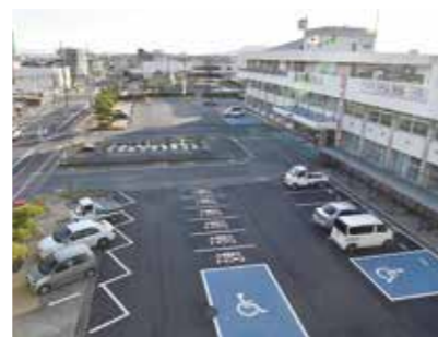
改修を終えた北側駐車場
