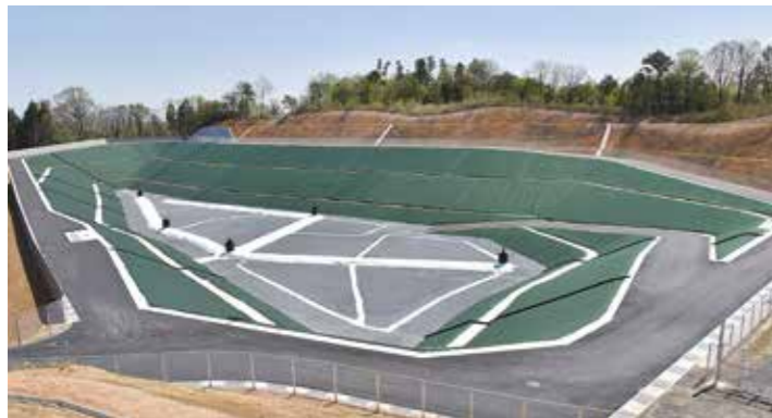
完成した最終処分場。遮水構造を採用し、処分場の隣には浸出水処理施設を設けている
