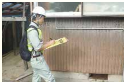
被災建築物を確認して回る
