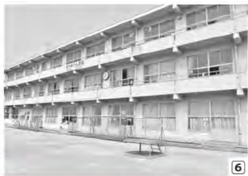
改築が行われる総社小学校。平成31年度中の完成予定
