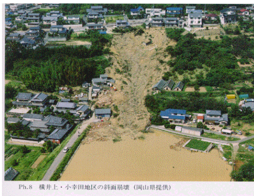
写真-1 斜面崩壊の例
