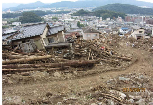
写真-2 2015 広島土石流災害
