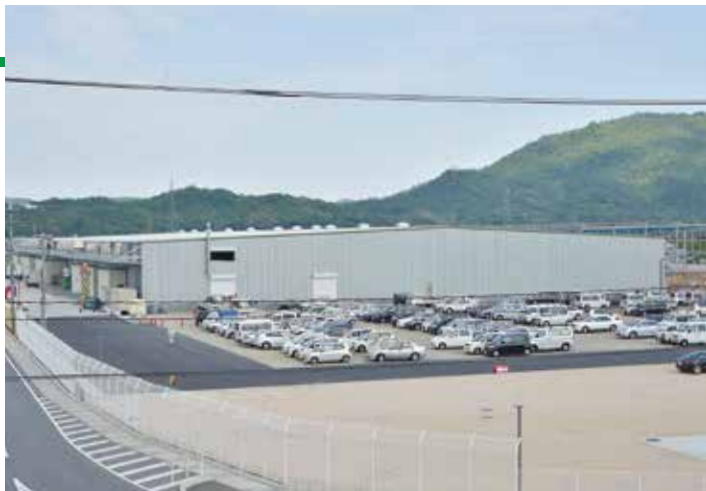
完成した R M チルド棟。奥ではドライ棟の建設が進む
