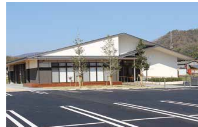
完成した西公民館久代分館
