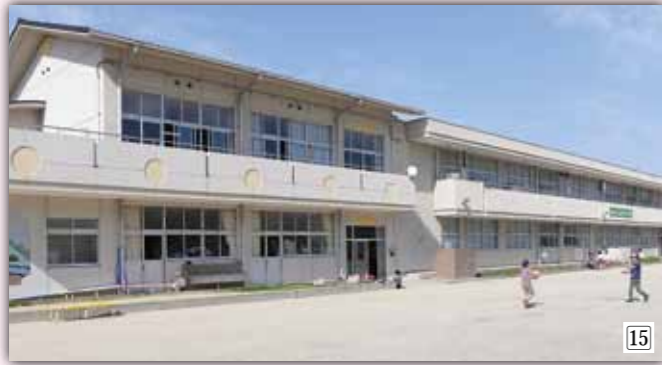
15 耐震補強される山手小学校の校舎
