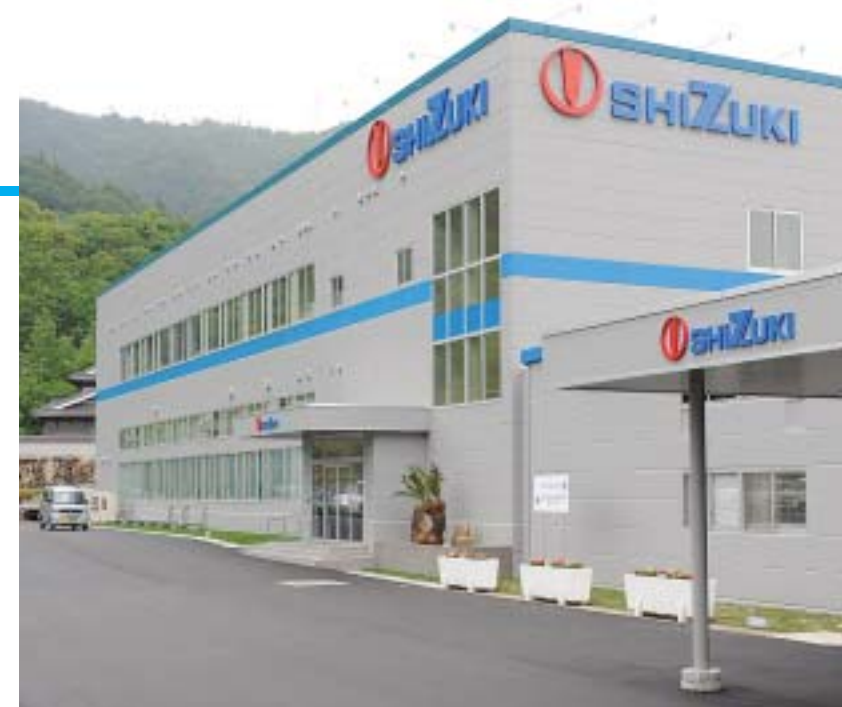
完成した指月電機製作所のR&Dセンター
