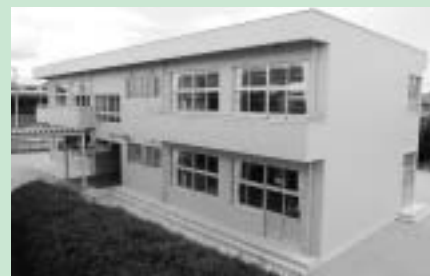
完成した校舎の外観
